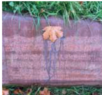
Schwarze Verfärbungen durch organische Objekte auf der jungen Oberfläche
